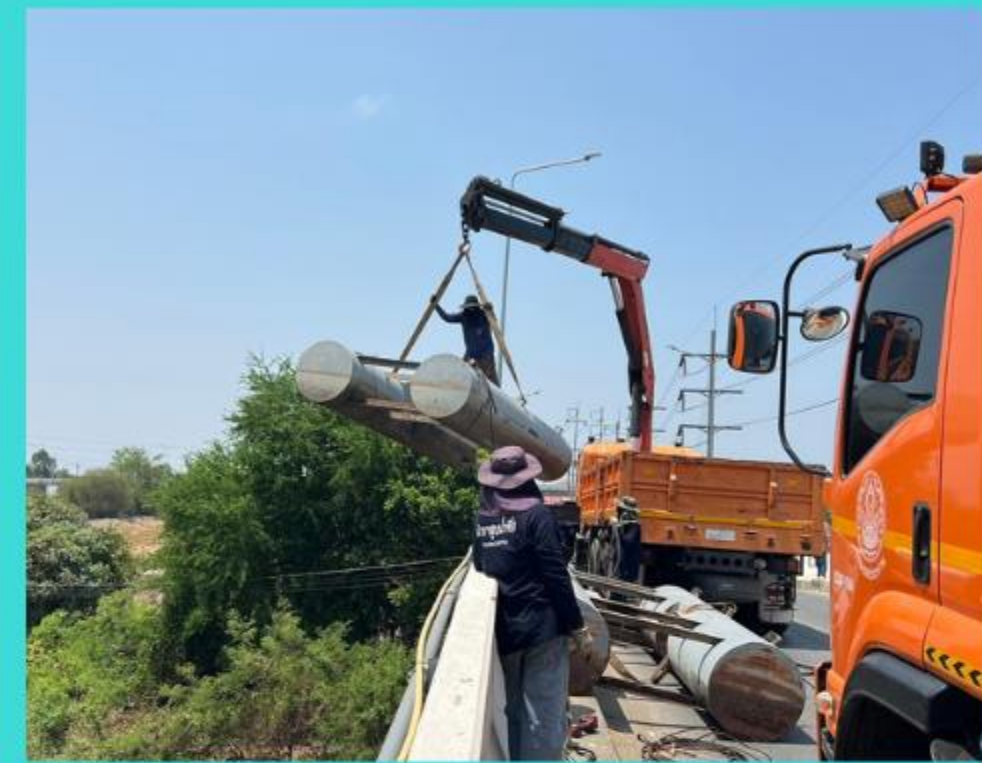
ติดตั้งเครื่องผลักดันน้ำ บริเวณสะพานแยกเกาะไร่ ตำบลเกาะไร่ อำเภอบ้านโพธิ์ จังหวัดฉะเชิงเทรา
