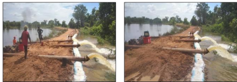
วันที่ 14 ต.ค. 66 ศป.ร้อยเอ็ด นำเครื่องสูบน้ำขนาด 8 นิ้ว จำนวน 3 เครื่อง เพื่อสูบน้ำท่วมซึ่งช่วยเหลือพื้นที่เพาะปลูก รวม 1,000 ไร่ ในเขต ต.คำไฮ อ.พนมไพร จ.ร้อยเอ็ด
