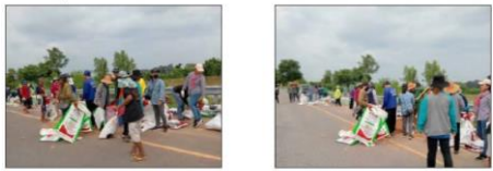
โครงการชลประทานร้อยเอ็ด ร่วมกับผู้นำท้องถิ่นและราษฎรในพื้นที่ ต.วังหลวง อ.เสลภูมิ ช่วยกันบรรจุกระสอบทรายเพื่อวางเป็นแนวป้องกันน้ำล้นตลิ่งบริเวณจุดเสี่ยงด้านข้าง ปตร.บ้านบาก
