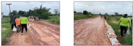
โครงการชลประทานร้อยเอ็ด ร่วมกับราษฎรในพื้นที่ ต.วังหลวง อ.เสลภูมิ ช่วยกันบรรจุกระสอบทรายเพื่อวางเป็นแนวป้องกันน้ำล้นตลิ่งบริเวณจุดเสี่ยงด้านข้าง ปตร.บ้านบาก
