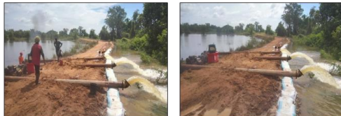
วันที่ 14 ต.ค. 66 ศป.ร้อยเอ็ด นำเครื่องสูบน้ำขนาด 8 นิ้ว จำนวน 3 เครื่อง เพื่อสูบน้ำท่วมซึ่งช่วยเหลือพื้นที่เพาะปลูก รวม 1,000 ไร่ ในเขต ต.คำโฮ อ.พนมไพร จ.ร้อยเอ็ด
