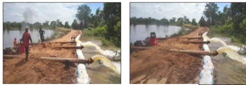
วันที่ 14 ต.ค. 66 ศป.ร้อยเอ็ด นำเครื่องสูบน้ำขนาด 8 นิ้ว จำนวน 3 เครื่อง เพื่อสูบน้ำท่วมซึ่งช่วยเหลือพื้นที่เพาะปลูก รวม 1,000 ไร่ ในเขต ต.คำโ อ.พนมไพร จ.ร้อยเอ็ด
