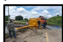
จุดที่ 5 ติดตั้งเครื่องสูบน้ำขนาด 12 นิ้ว อ.แสวงหา จ.อ่างทอง
