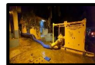
จุดที่ 1, 2 ติดตั้งเครื่องสูบน้ำขนาด 12 นิ้ว อ.เมือง จ.อ่างทอง
