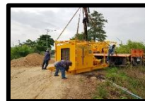
จุดที่ 4 ติดตั้งเครื่องสูบน้ำขนาด 12 นิ้ว อ.วิเศษชัยชาญ จ.อ่างทอง
