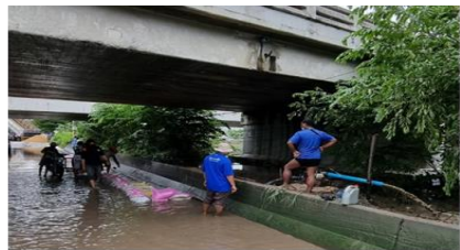
คลองขุดใหม่ อ.ลาดหลุมแก้ว จ.ปทุมธานี
