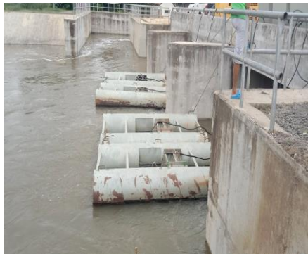
ติดตั้งเครื่องสูบน้ำที่ปตร.กันผม เพื่อช่วยเร่งระบายน้ำลงลำน้ำมูล
