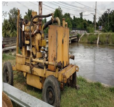
ติดตั้งเครื่องสูบน้ำที่ปตร.กันผม เพื่อช่วยเร่งระบายน้ำลงลำน้ำมูล
