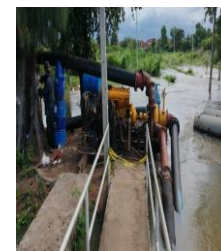
เครื่องผลักดันน้ำและเครื่องสูบน้ำที่ติดตั้งในลำบริบูรณ์และลำตะคอง
