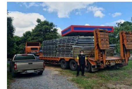
ติดตั้งสะพานเบลิย บริเวณสะพานบ้านวัดวอ ต.ท่าดี
