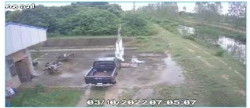
โรงสูบน้ำระยะล่งเรือ 1-2 กม. 50+500
