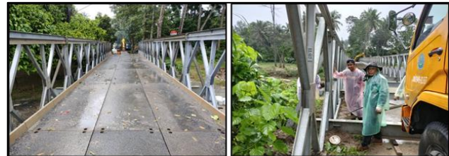
ติดตั้งสะพานบ่อบี บริเวณสะพานบ้านวัวควอ หมู่ที่ 2 ต.พาที อ.ลานสกา จ.นครศรีธรรมราช ความเก็บหน้า 90%
