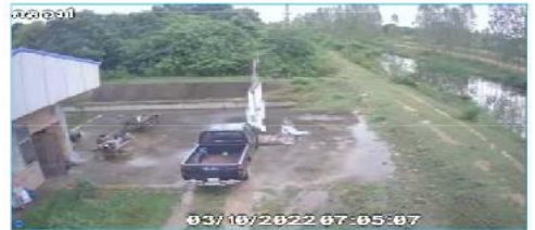
โรงสูบน้ำระยะเร่ง 1-2 กม. 50+500
