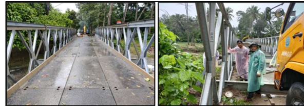
ติดตั้งสะพานบลิ๊ต บริเวณสะพานบ้านวัวควง หมู่ที่ 2 ต.ท่าดี อ.ถาสนก จ.นครศรีธรรมราช ความแข็งแรง 90%
