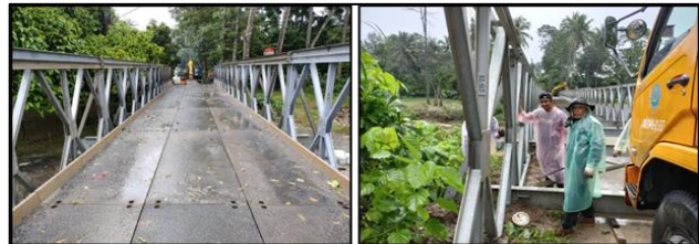
ติดตั้งสะพานเบสท์ บริเวณสะพานบ้านวัวควอ หมู่ที่ 2 ต.พาที อ.ลานสกา จ.นครศรีธรรมราช ความแข็งแรง 90%
