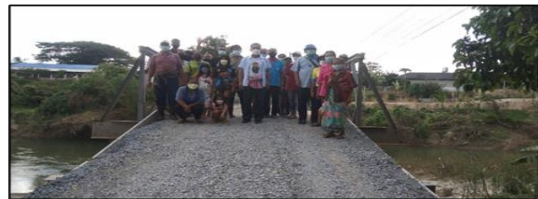
ติดตั้งสะพานบดสี่ บริเวณสะพานบ้านวัดควอ หมู่ที่ 2 ต.ท่าดี อ.ลานสกา จ.นครศรีธรรมราช แล้วเสร็จ 100% เมื่อเวลา 21.45 น. 11 ธ.ค. 2564
