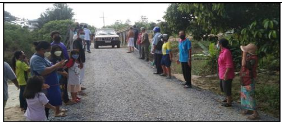
ติดตั้งสะพานเบลิย์ บริเวณสะพานบ้านวัดควอ หมู่ที่ 2 ต.ท่าดี อ.ลานสกา จ.นครศรีธรรมราช เปิดใช้สะพานแล้ว เมื่อวานนี้
