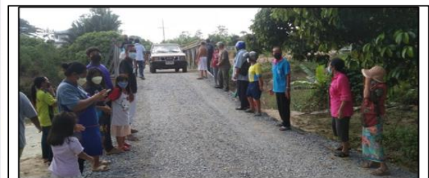
ติดตั้งสะพานเบสิค บริเวณสะพานบ้านวัดควอ หมู่ที่ 2 ต.ท่าดี อ.ลานสกา จ.นครศรีธรรมราช เปิดใช้สะพานแล้ว เมื่อวานนี้
