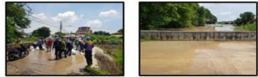
น้ำเริ่มซึมลอดกำแพงเขาดลองข้างวัดไชโย ม.2 ต.ไชโย อ.ไชโย จ.อ่างทอง
