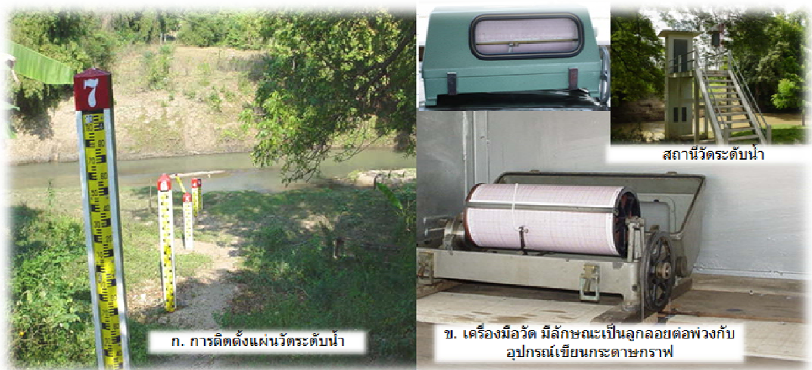
ภาพที่ 2 การติดตั้งแผ่นวัดระดับน้ำ และเครื่องมือวัดระดับน้ำแบบลูกลอย
