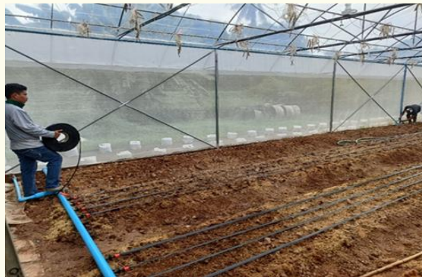
การต่อระบบส่งน้ำด้วยระบบน้ำหยด (เทปน้ำหยด)
