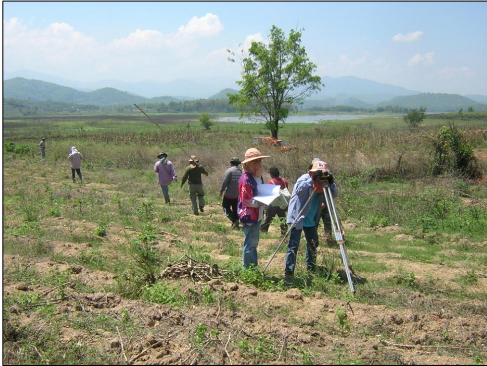
รูปที่ ก-5 การสำรวจระดับภูมิประเทศโดยรอบอ่างเก็บน้ำด้วยวิธีรังวัด
