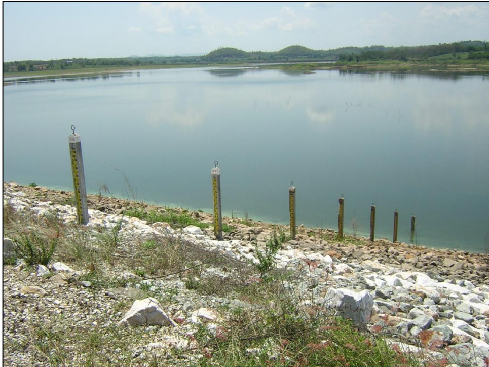
รูปที่ ก-1 ลักษณะภูมิประเทศโดยรวมของอ่างเก็บน้ำห้วยขุนแก้ว
