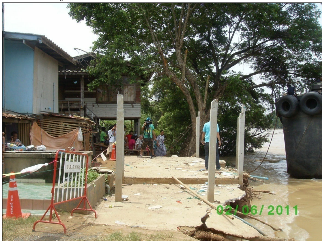
รูปที่ 5 แนวตลิ่งที่ถูกกัดเซาะเนื่องจากกระแสน้ำเปลี่ยนทิศทาง
