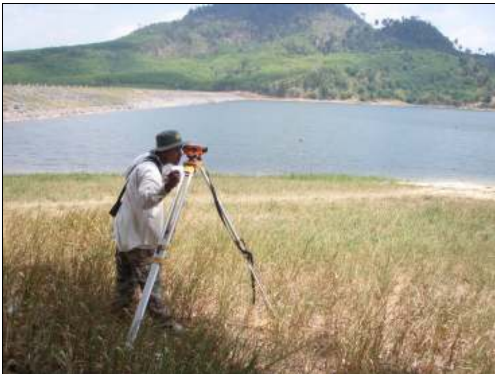
รูปที่ ง-4 การสำรวจระดับโยจราคาหมดหลักฐาน
