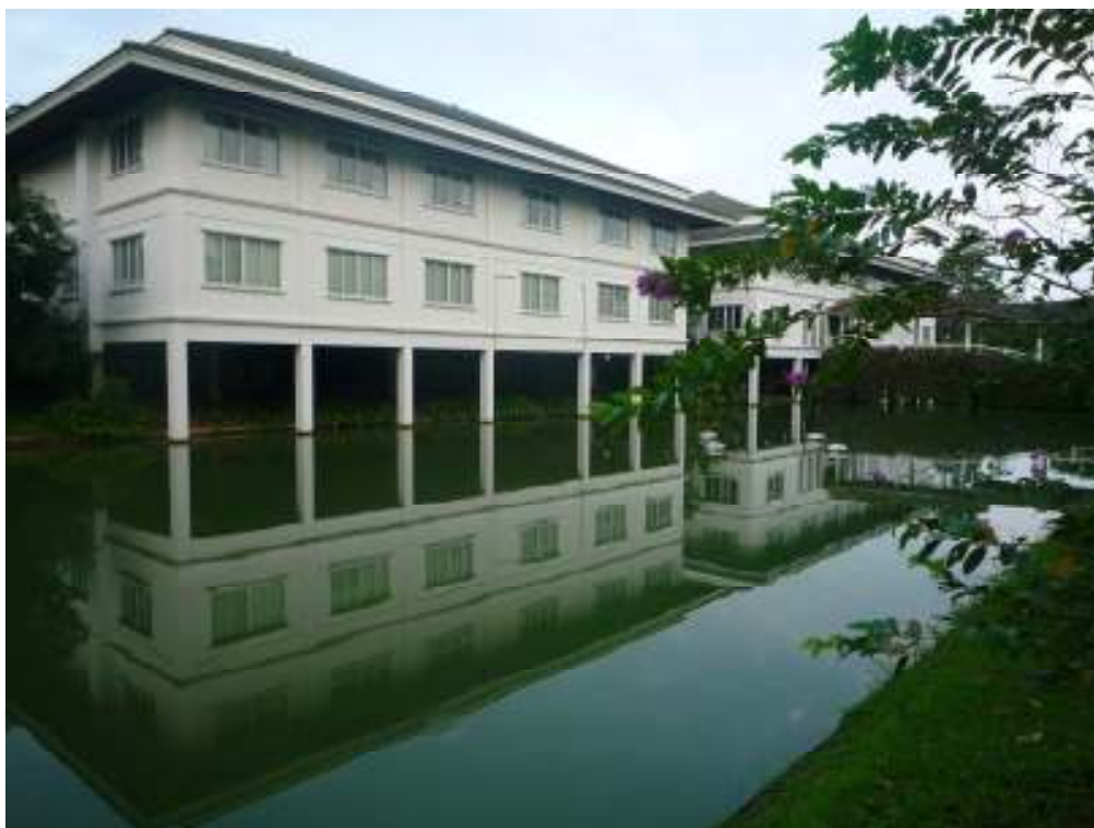
ภาพที่ ค-4 สภาพโดยทั่วไปของจุดสำรวจคุณภาพน้ำจุดตรวจวัด 2
