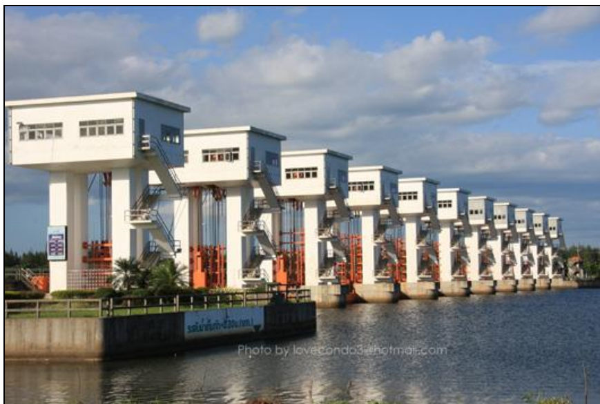
รูปที่ ๕๗ ประตูระบายน้ำอุทกวิภาชประสิทธิ์
