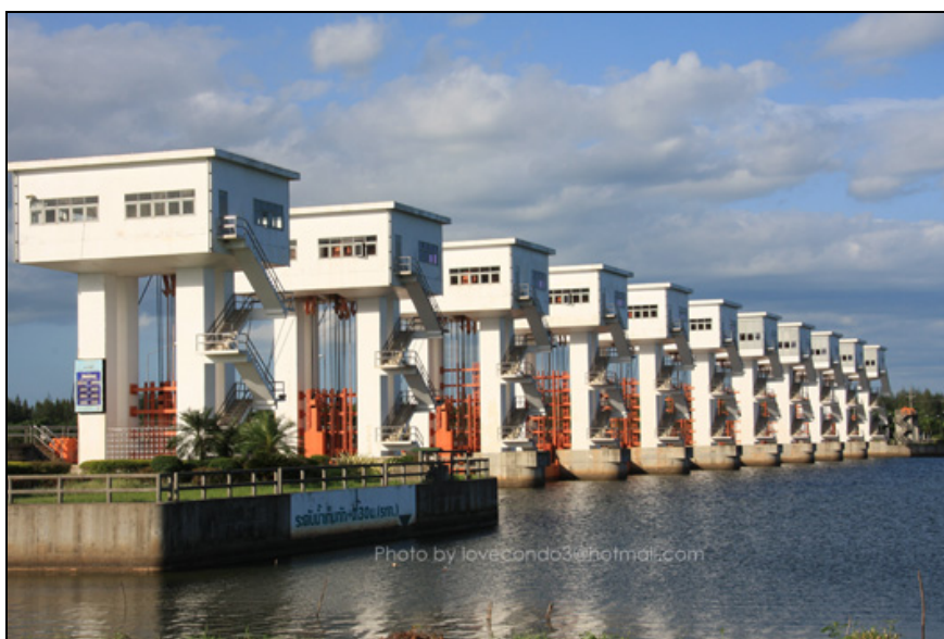
รูปที่ ๔๘ ประตูระบายน้ำอุทกวิภาชประสิทธิ์
