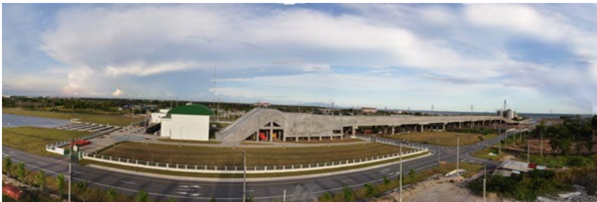
รูปที่ 41 ภาพแสดงโครงการระบายน้ำสายใหม่ (สนามบินสุวรรณภูมิ)
