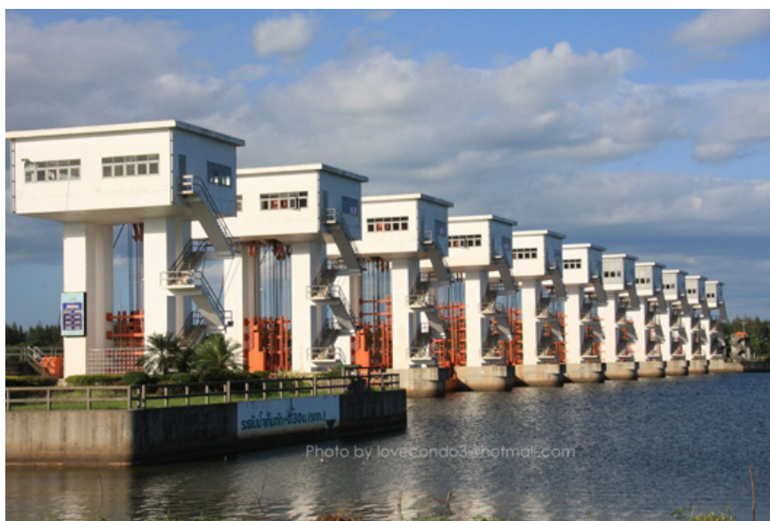
รูปที่ 40 ประตูระบายน้ำอุทกวิภาชประสิทธิ์
