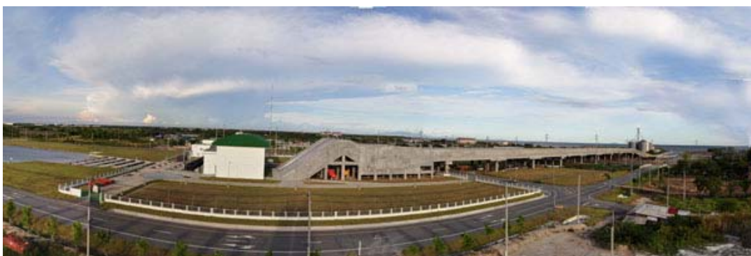
รูปที่ ๓๓ ภาพแสดงโครงการระบายน้ำสายใหม่(สนามบินสุวรรณภูมิ)
