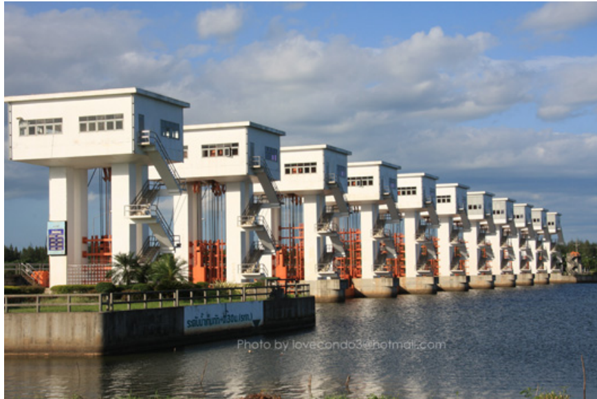
รูปที่ ๔๔ ประตูระบายน้ำอุทกวิภาชประสิทธิ์
