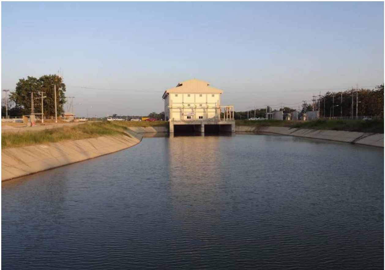
อาคารระบายน้ำท้ายโรงไฟฟ้าพลังน้ำเขื่อนแม่งลอง
