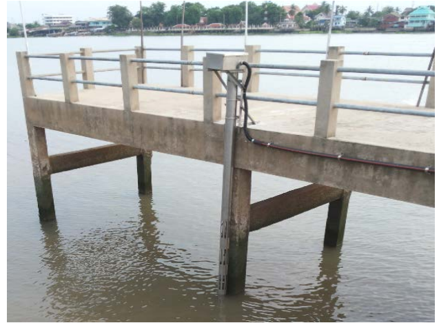
รูปที่ 14 ติดตั้งริมตลิ่งหรือติดตั้งบริเวณ ตอม่อสะพาน ( กรมชลประทาน )
