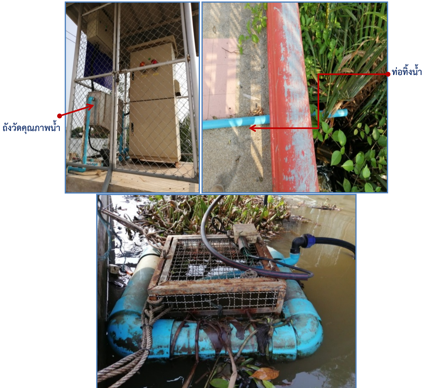
ท่อนสูบน้ำเข้าถังวัดคุณภาพน้ำ
