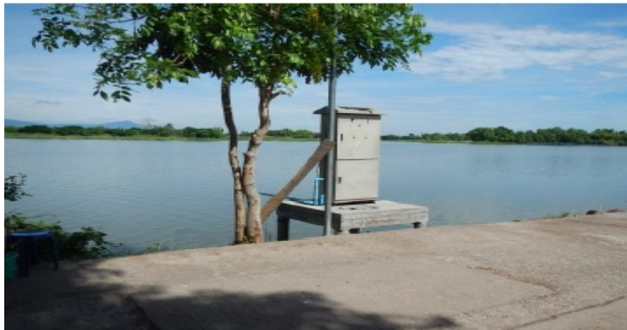
รูปที่ 11 ตู้ตรวจวัดคุณภาพน้ำ ( กรมควบคุมมลพิษ )
