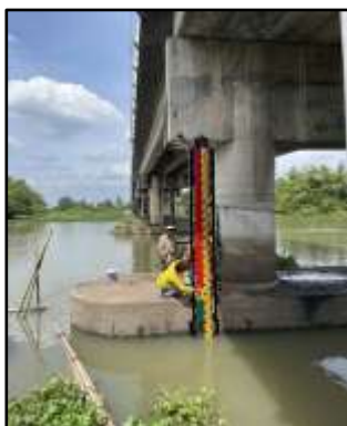
รูปที่ ๑๒ ดำเนินการติดตั้งเสาสถิติระดับน้ำ
