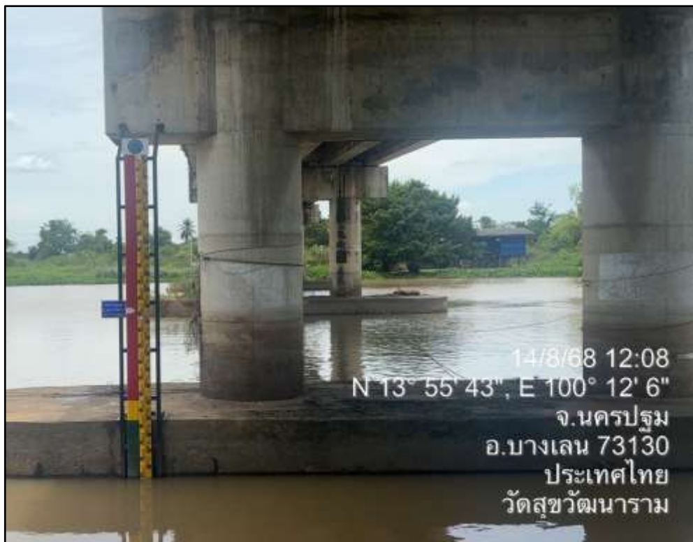
รูปที่ ๑๓ เสาสถิติระดับน้ำ
