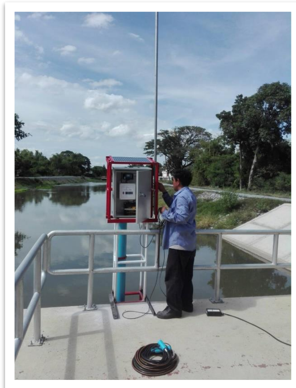
รูปที่ 13 การเข้าประกอบหัวสายสัญญาณวัดระดับน้ำ
