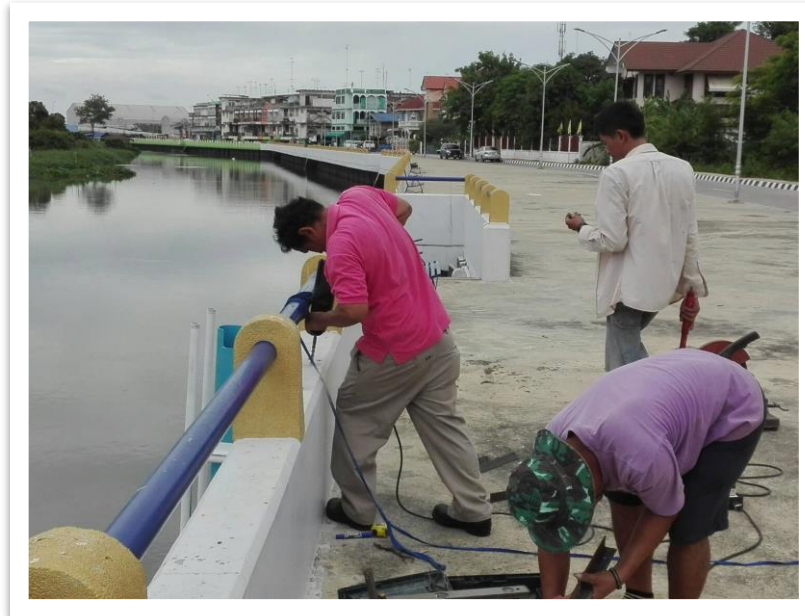
รูปที่ 9 ติดตั้งโทรมาตรวัดระดับน้ำที่หลังตลาด อ.สองพี่น้อง
