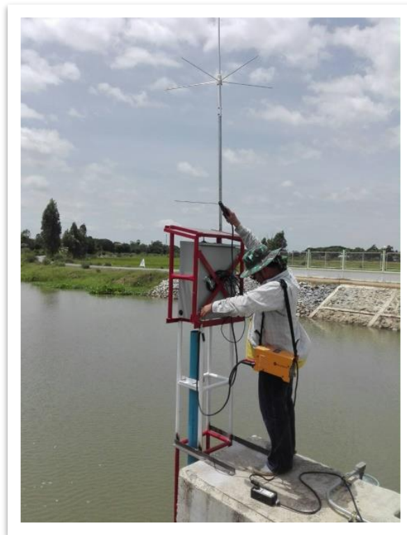
รูปที่ 11 การติดตั้งสายอากาศรับส่งสัญญาณข้อมูลวัดระดับน้ำของโทรมาตร
