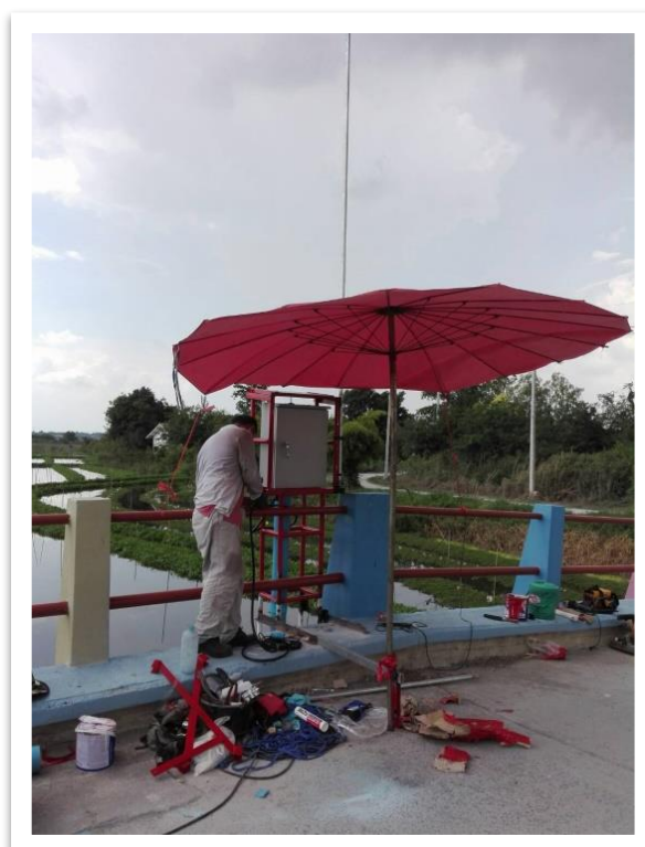
รูปที่ 16 การติดตั้งโทรมาตรที่สะพานหนองกุ่ม คลองระบายน้ำ อ.สองพี่น้อง
