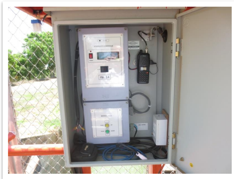
รูปที่ 17 การตรวจสอบระบบเกียร์มอเตอร์ควบคุมการปรับบานประตูระบายน้ำ
