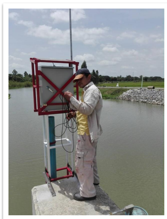
รูปที่ 12 การประกอบเชื่อมต่อ sensor วัดระดับน้ำ
