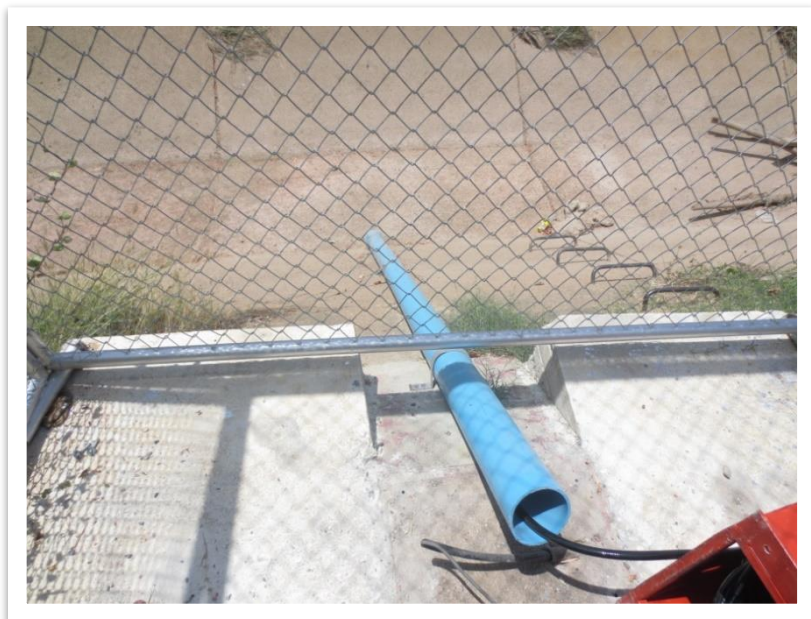
รูปที่ 20 การติดตั้ง sensor เปรียบเทียบแรงดันน้ำ
