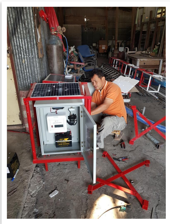
รูปที่ 3 การเตรียมติดตั้งแผงโซลาร์เซลล์
