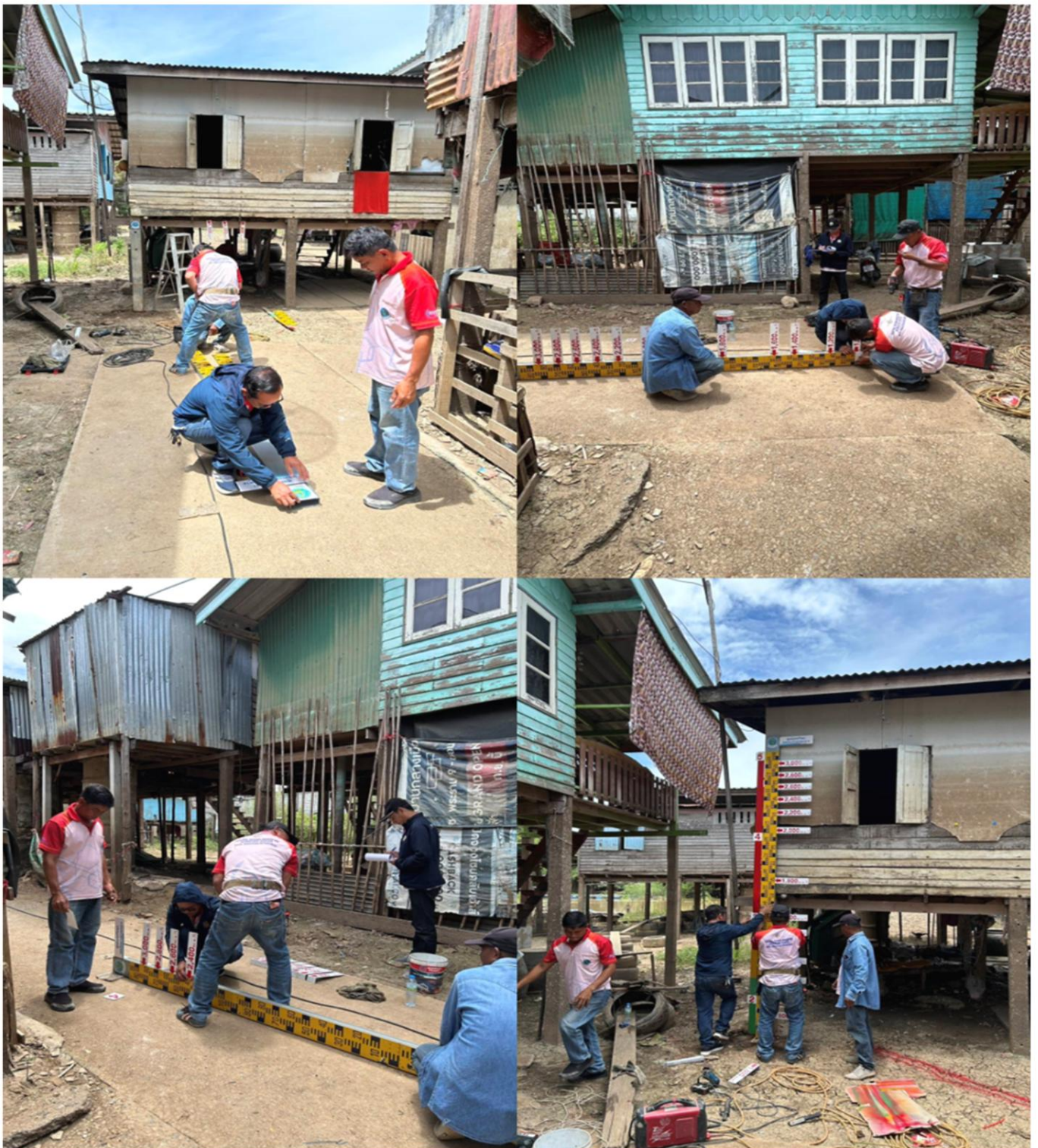
ติดตั้งเสาสถิติระดับน้ำ
