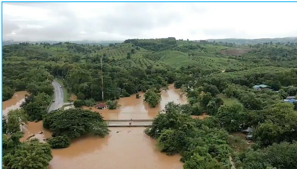
รูปภาพที่ 8 สภาพน้ำท่วม ที่สถานี S.33
