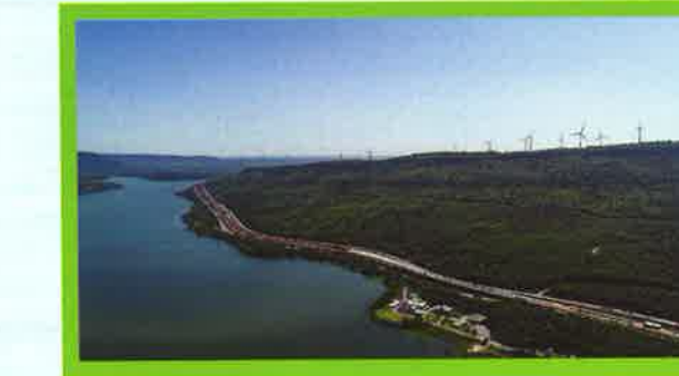
9. เขื่อนลำตะคอง จังหวัดนครราชสีมา เพื่อกักเก็บน้ำไว้อุปโภคบริโภค การเกษตร และลดอุทกภัย เขื่อนลำตะคอง สร้างขึ้นบริเวณ ช่องเขาเขื่อนล้นกับช่องเขาถ่านเสียตัว ก่อสร้าง ปี 2512 แล้วเสร็จ ปี 2517
