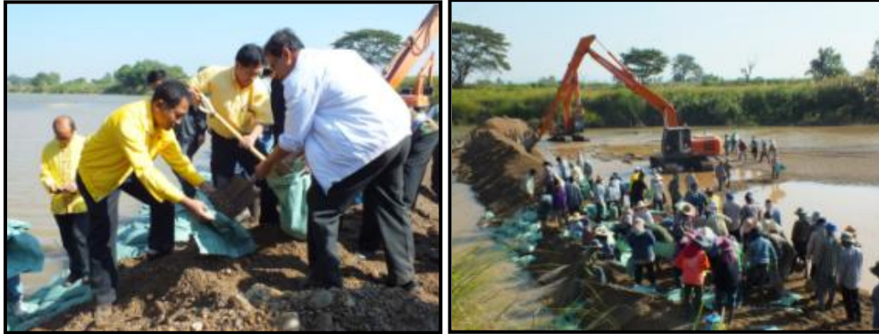
รูปที่ 12 กลุ่มผู้ใช้น้ำร่วมกันสร้างงานชั่วคราวด้วยกระสอบทรายในลำน้ำยม
