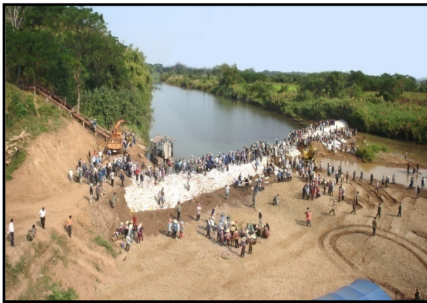
รูปที่ 9 การสร้างทำนบชั่วคราวกั้นลำน้ำยมและการประชุมชี้แจงกลุ่มผู้ใช้น้ำ ชป.แพร่
