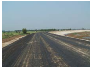
ก่อสร้างถนน
