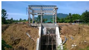
ก่อสร้างอาคารบังคับน้ำ
