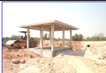
อาคารจ่ายน้ำ
