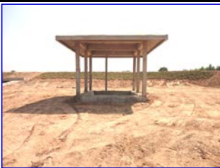
อาคารจ่ายน้ำ
