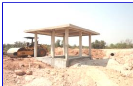
อาคารจ่ายน้ำ
