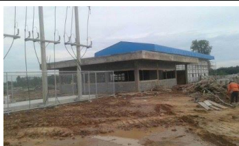
ขณะดำเนินการก่อสร้าง
