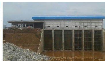
ขณะดำเนินการก่อสร้าง
