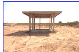
อาคารจ่ายน้ำ
