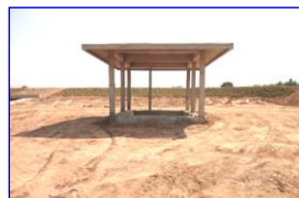
อาคารจ่ายน้ำ
