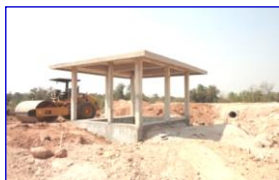
อาคารจ่ายน้ำ
