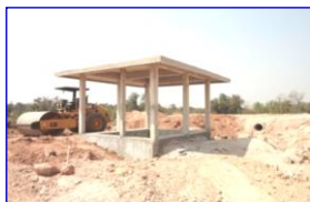
อาคารจ่ายน้ำ
