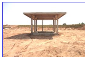
อาคารจ่ายน้ำ
