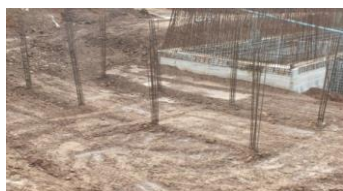
ขณะดำเนินการก่อสร้าง
