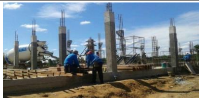
ขณะดำเนินการก่อสร้าง
