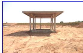
อาคารจ่ายน้ำ
