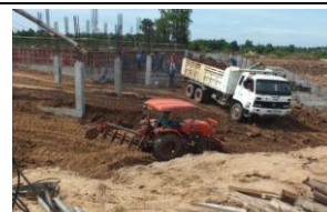
ขณะดำเนินการก่อสร้าง
