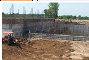
ขณะดำเนินการก่อสร้าง
