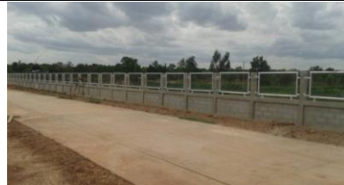
ดำเนินการก่อสร้างแล้วเสร็จ
