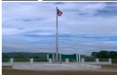
ดำเนินการก่อสร้างแล้วเสร็จ
