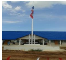
ดำเนินการก่อสร้างแล้วเสร็จ
