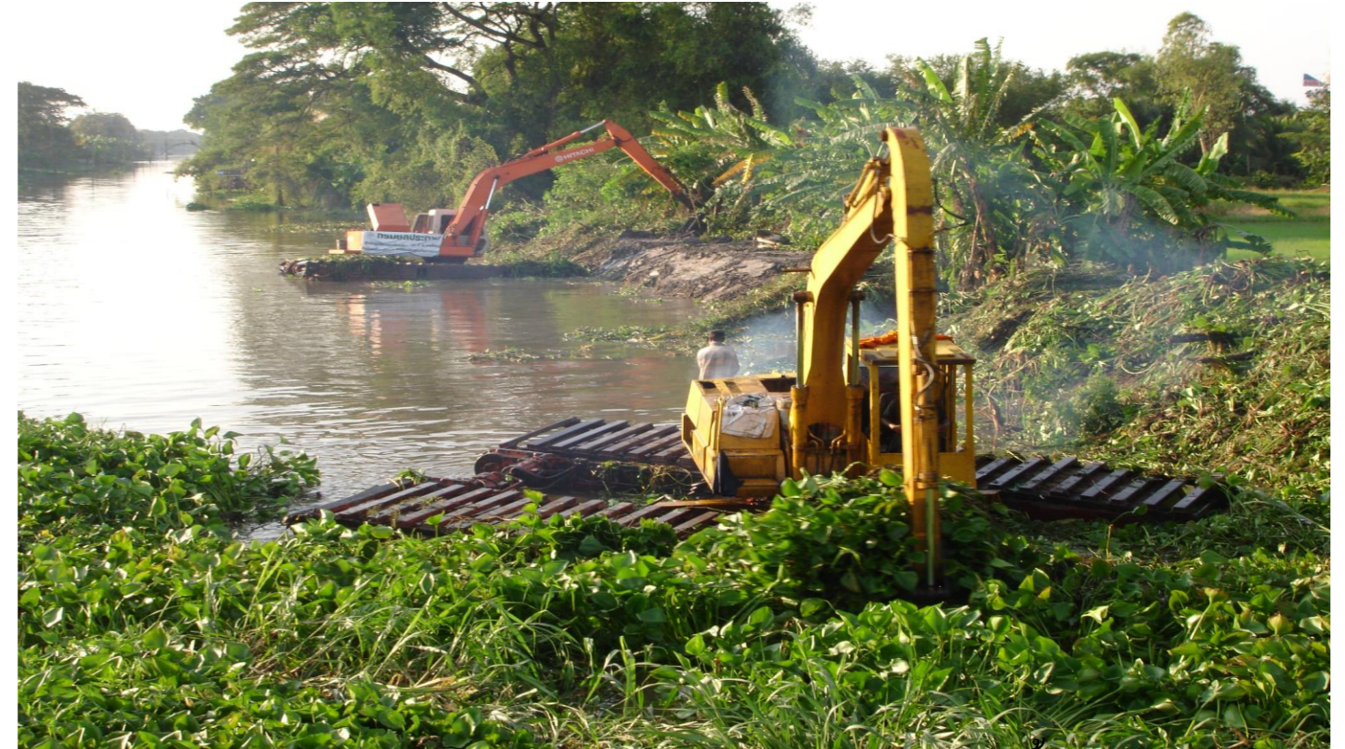
2. รถขุด MARSH BACKHOE (ทำงานในน้ำ)
