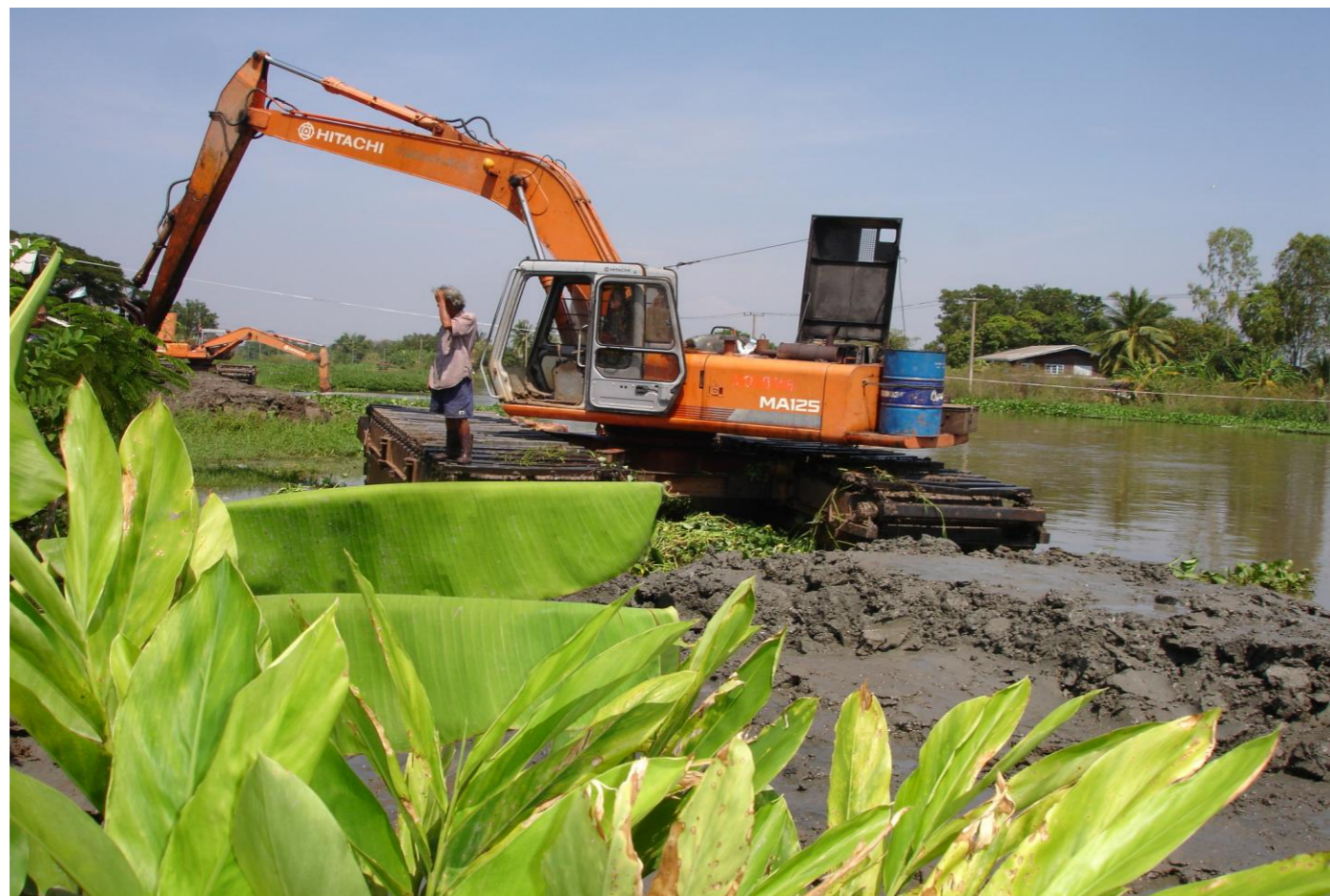
3. รถขุด MARSH BACKHOE (ทำงานบนบก)
