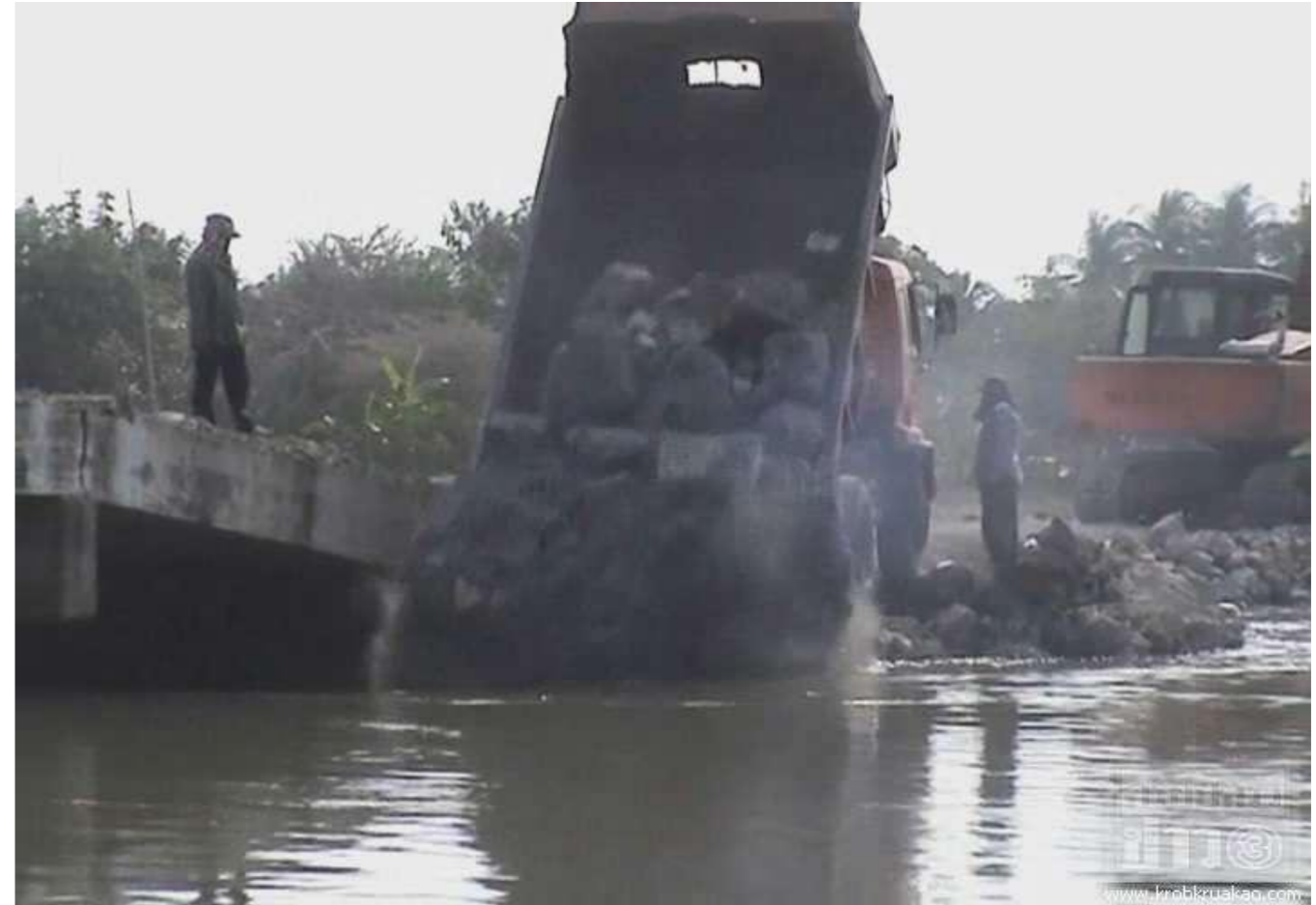
ภาพแสดงลักษณะการปฏิบัติงานของเครื่องจักร (ซ่อมแซมกูกันกันน้ำบางโจมศรี)
