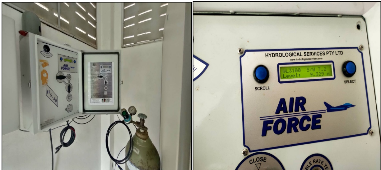
รูปที่ 5 ตัวอย่างเครื่องมือวัดระดับน้ำแบบใช้แรงดันอากาศ
