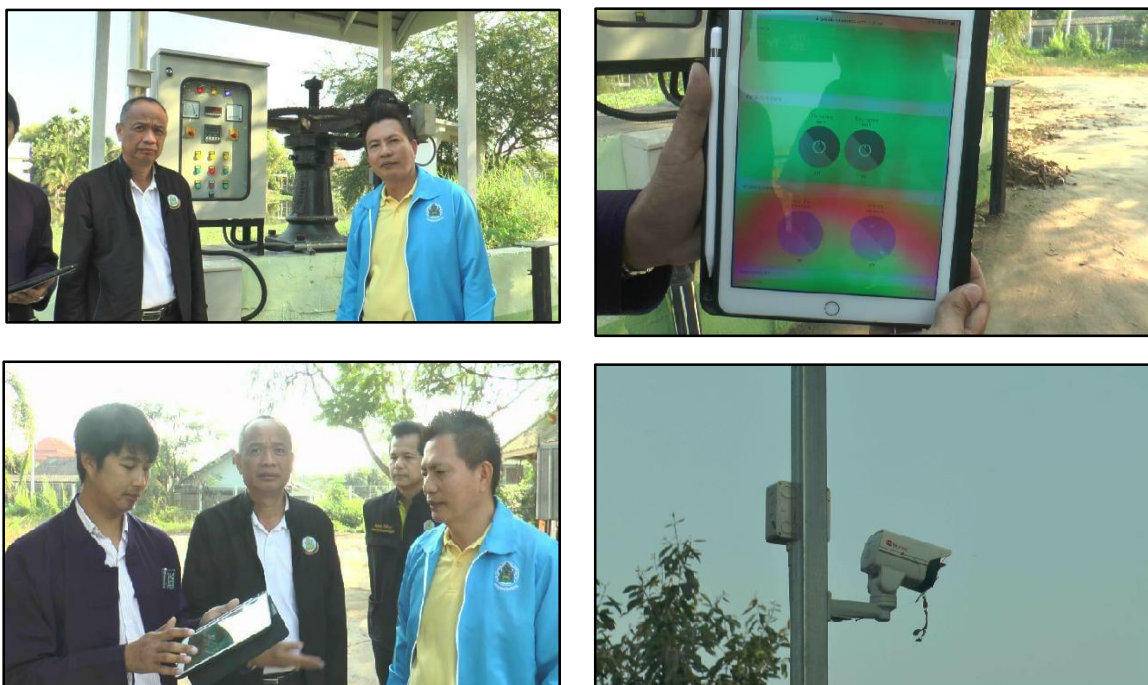
รูปที่ 3-40 การทดสอบระบบเปิด-ปิด ประตูระบายน้ำผ่าน Mobile Application
