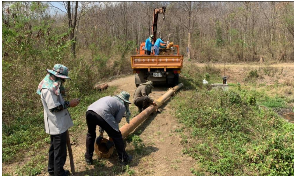
รูปที่ 3-13 โครงการชลประทานเชียงใหม่ ลงพื้นที่ติดตั้งเครื่องสูบน้ำ เพื่อช่วยเหลือเกษตรกรบ้านหนองหอย หมู่ที่ 2 ตำบลออนเหนือ อำเภอแม่ออน จังหวัดเชียงใหม่
