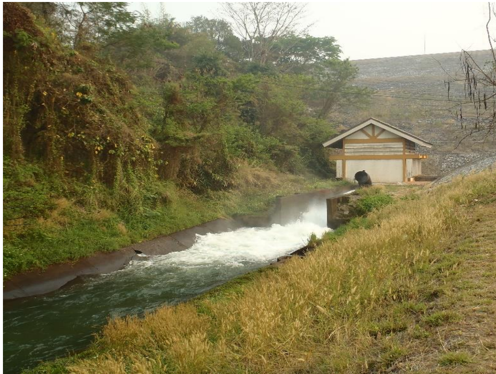
รูปที่ 3-7 อาคารปากคลองจากท่อ OUTLET ของคลองส่งน้ำสายใหญ่ฝั่งขวาของฝ่ายส่งน้ำและบำรุงรักษาที่ 3
