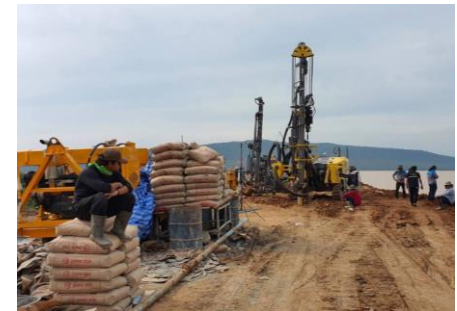
อัดฉีดน้ำปูนและสารเคมี
