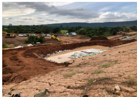
ถมคันดินด้านท้ายน้ำ
