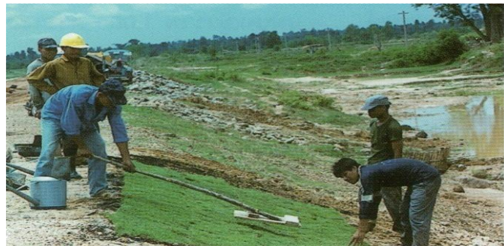
การวางแผ่นหญ้าปลูกลงบนเชิงลาดบนคันดิน
