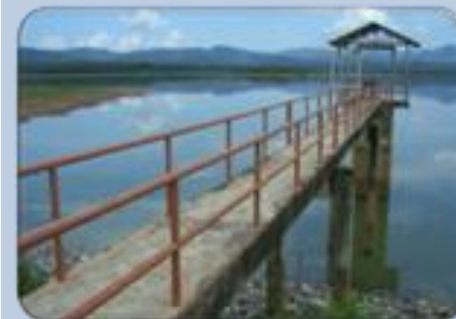
อาคารระบายน้ำ/ส่งน้ำ (Outlet)
