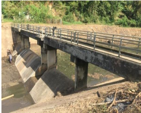
ฝายคอนกรีต
