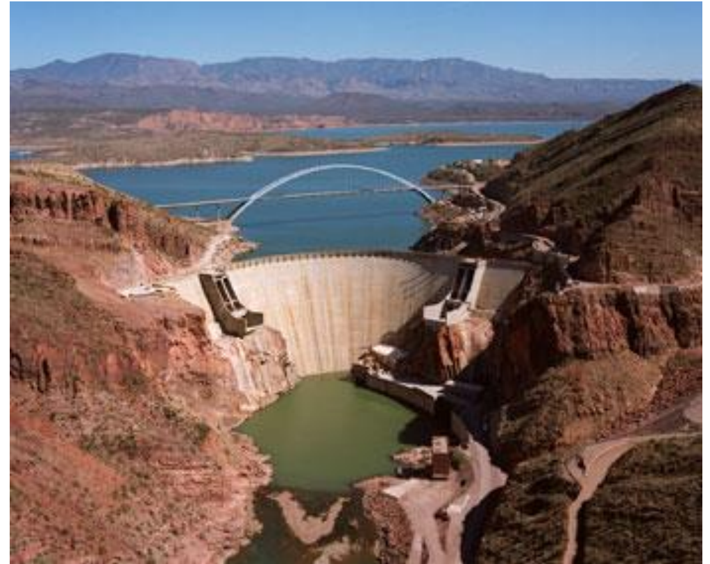
Roosevelt Dam, original masonry construction, completed 1911 (พ.ศ. 2454) สูง 84 m. ยาว 216.9 m.
